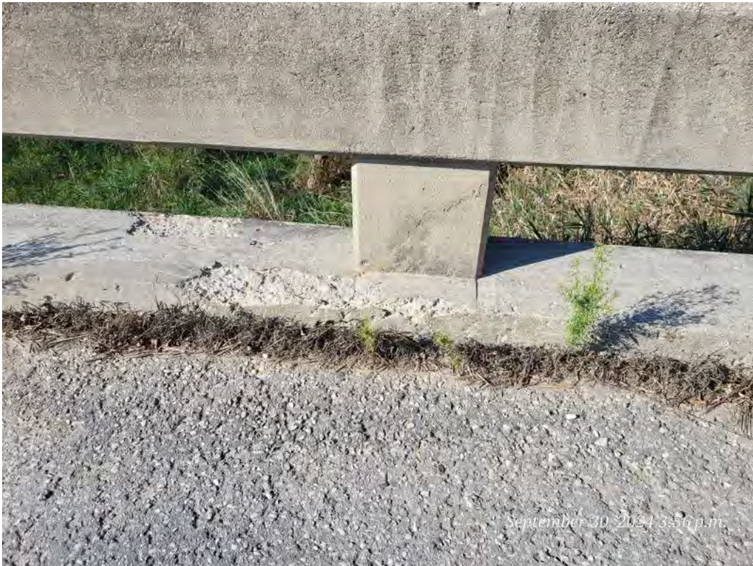
05 - Curb Spalling
